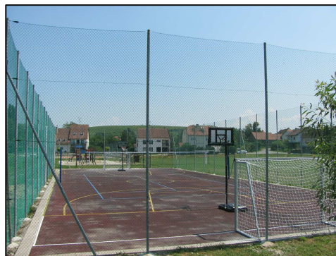
Foto po realizaci
